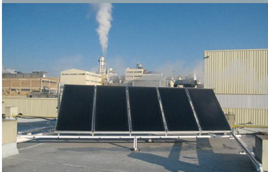
Progetti pilota: in Spagna presso i siti di Siviglia e di Montornès (foto) sono stati installati impianti solari termici su scala ridotta. Questi impianti utilizzano il calore proveniente dalla radiazione solare per la produzione di acqua calda destinata agli stabilimenti.
